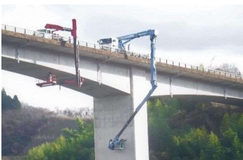
橋梁の点検状況 県道白丹竹田線（竹田市）
