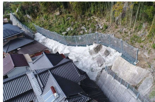
急傾斜地崩壊対策事業 田平地区（日田市）
