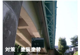
橋梁の補修状況 県道別府山香線 御門橋（別府市）
