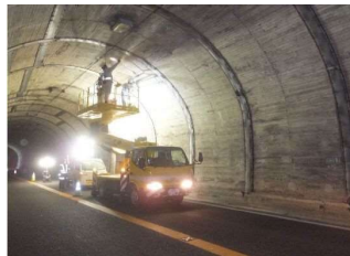
トンネル点検状況 国道213号（杵築市）
