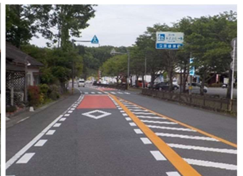
国道 502 号（豊後大野市） 区画線・注意喚起表示 薄層カラー舗装
