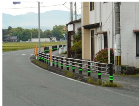
一般県道 渋見成恒中津線（中津市） ガードパイプ・視線誘導標設置
