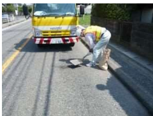
異常箇所の早期発見・補修
