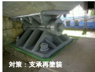
橋梁の補修状況 県道別府山香線 御門橋（別府市）
