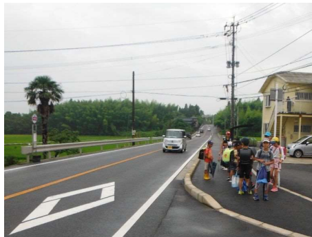
一般県道国東安岐線（国東市） 自転車歩行者道整備
