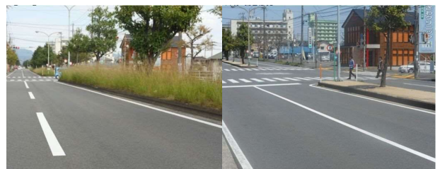
中央分離帯の防草対策
