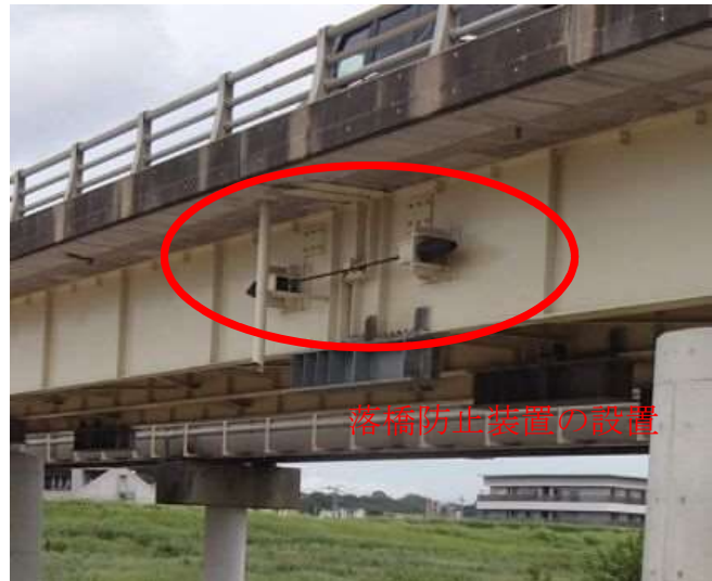
耐震補強の事例（大分白杵線 高田橋）
