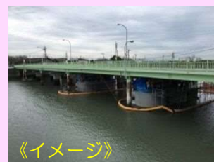
橋梁耐震化工事
