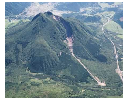
平成25年、「後世に伝えるべき治山」 由布岳治山ダム群
