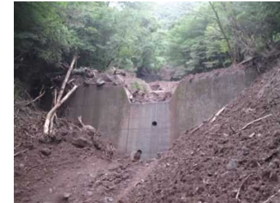
平成24年災害治山ダムによる土石流の抑止
