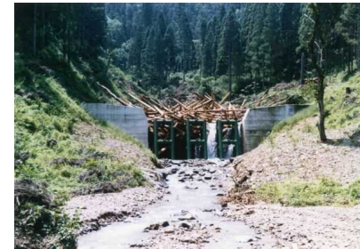
平成5年災害スリットダムによる流木捕捉
