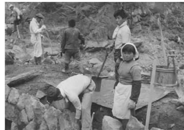
練積堰堤工の施工
