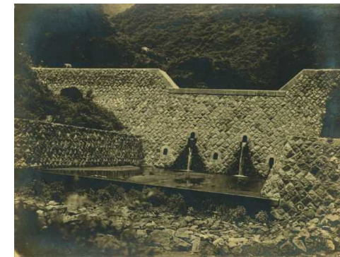
昭和初期の練積堰堤工
