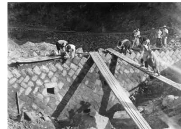
練積堰堤工の施工
