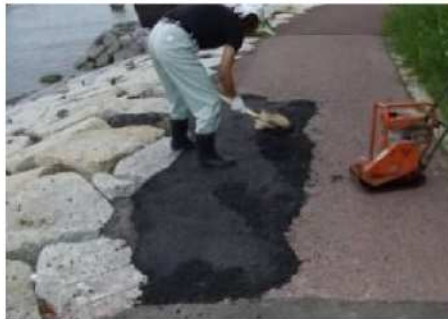
◇管理道の小規模な補修
