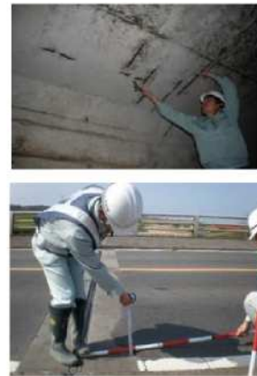
【定期点検状況】
