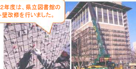
【県立図書館の外壁改修】
