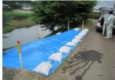
◇災害拡大防止のための応急処理
