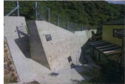
【急傾斜地崩壊対策事業：徳納地区(佐伯市)】
