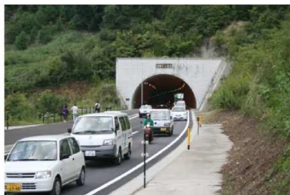
【国道217号佐伯弥生バイパス 供用箇所状況】
