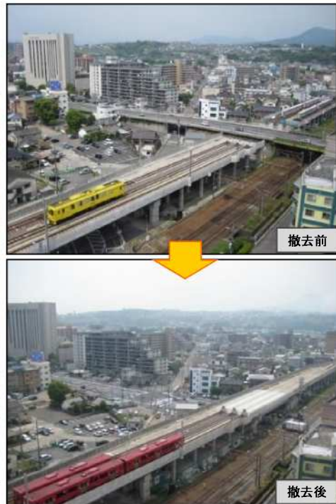
【大道陸橋撤去工事】
