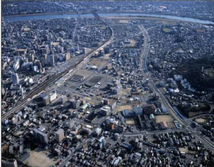
【工事が進む大分駅周辺総合整備事業】
