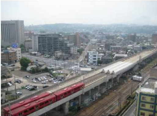
【大道陸橋撤去完了後】H23.6
