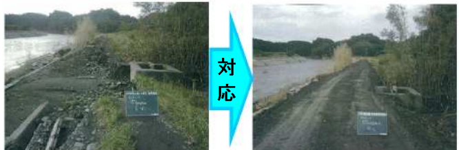
【河川管理道の補修】
