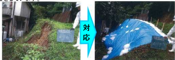
【崩壊法面の保護】
