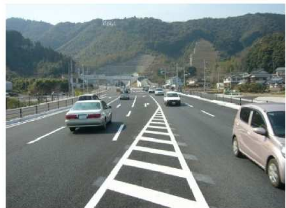
【国道217号佐伯弥生バイパス 供用箇所状況】
