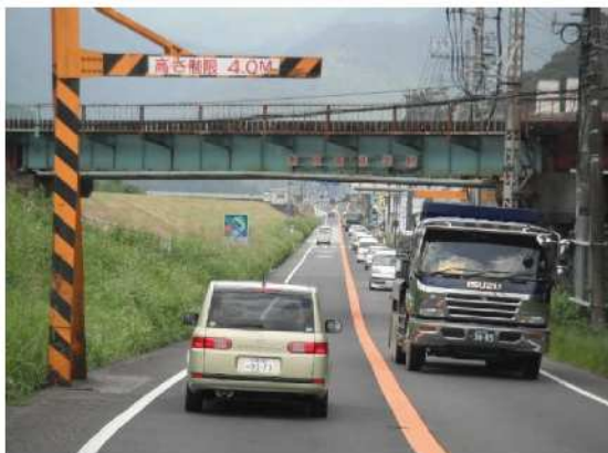
【国道217号 整備前の現道状況】
