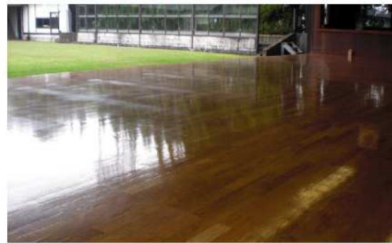
【大洲総合運動公園 弓道場床改修】
