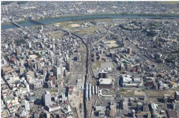
【概成した大分駅付近連続立体交差事業】H24.10
