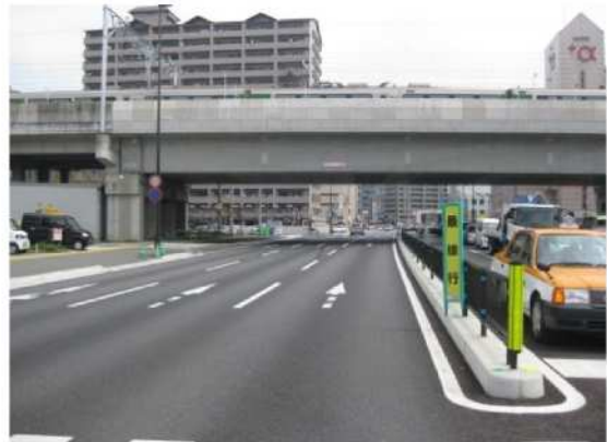
【国道210号 田室仮踏切(大道陸橋跡)】H24.5
