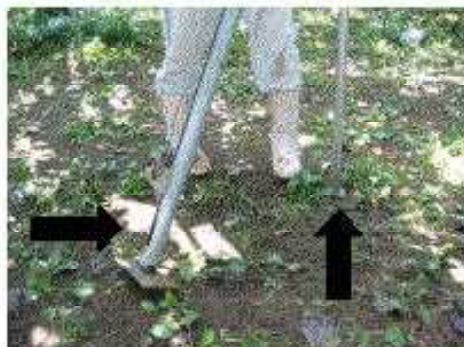
器具と臨時支柱の下部
