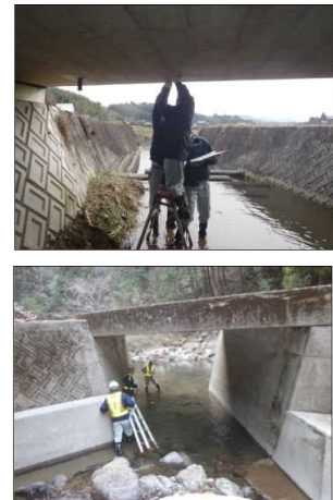
【定期点検状況】
