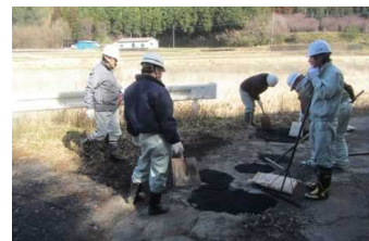
【職員による河川管理道の陥没箇所の補修作業】
