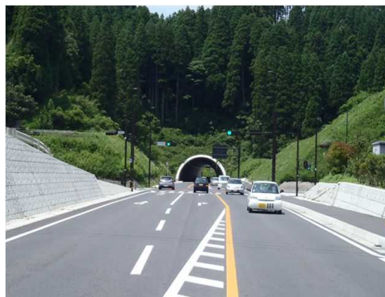
【国道387号町田バイパス 開通後の状況】
