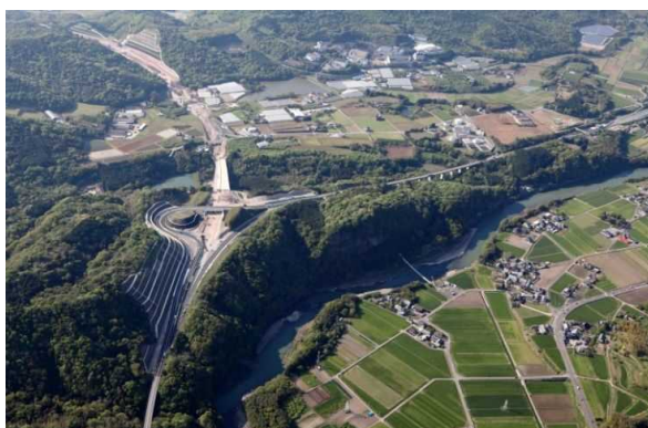
【東九州自動車道宇佐IC付近の整備中の状況】
