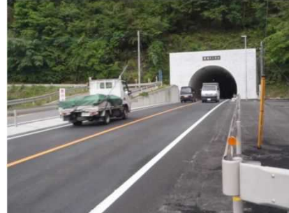
【県道栃野西大山線西大山工区(日田市大山町)】
