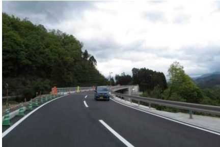
【国道442号野津原バイパス(大分市下詰～今市)】
