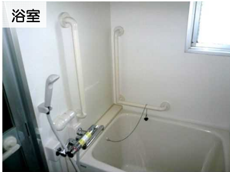
浴室 手すり、給湯器、シャワーを設置しました。
