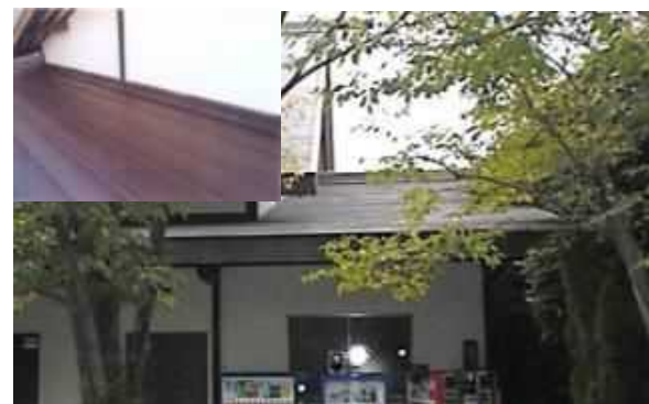
【大洲総合運動公園 弓道場屋根改修】
