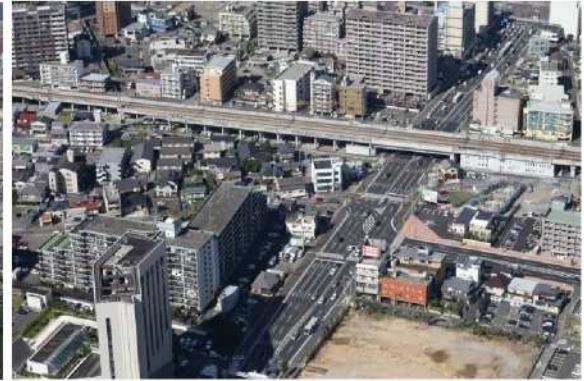
【国道210号(踏切撤去後)】H24.9
