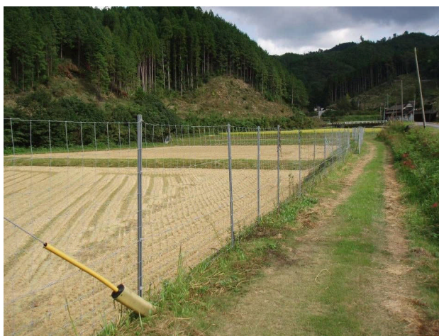
イノシシ、シカの侵入を防ぐ金網柵の設置
