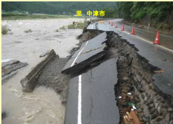
●山国川増水による兼用護岸の流出 (中津市耶馬溪町戸原)
