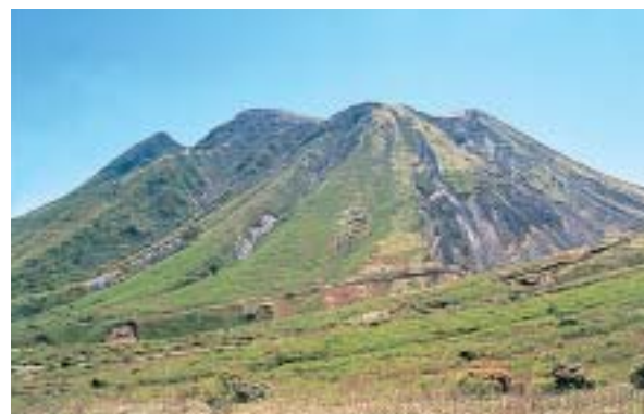
崩壊した土砂は谷を下り湿原を埋めていく
