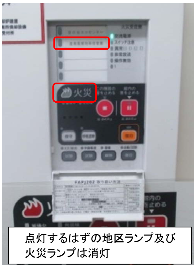
平簪(ひらばえ)守衛所火災受信機盤
