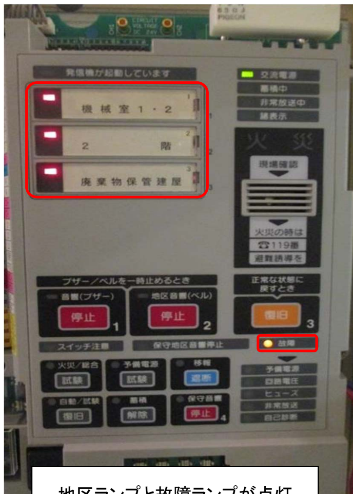
産業廃棄物等保管庫(産業廃棄物他処理建屋)火災受信機盤
