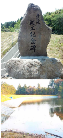
竣工記念碑と改修後の奥迫池
