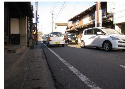
車が行き交い段差のある路肩
