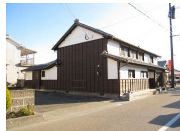
修景整備(整備後)
