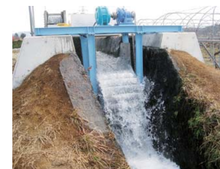
地場企業によるマイクロ水力発電システムの実証機（日田市）
