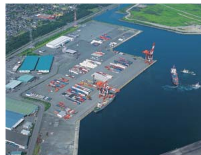
大分港大在コンテナターミナル
