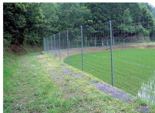
防護柵の設置により有害鳥獣被害を軽減
