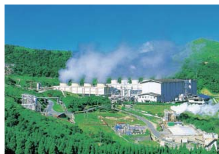
八丁原発電所
