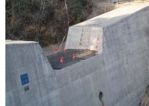
【監視観測機器の整備状況(新燃岳噴火時の緊急対策 左:監視カメラ、右:ワイヤーセンサ)】 (九州地方整備局宮崎河川国道事務所提供)
