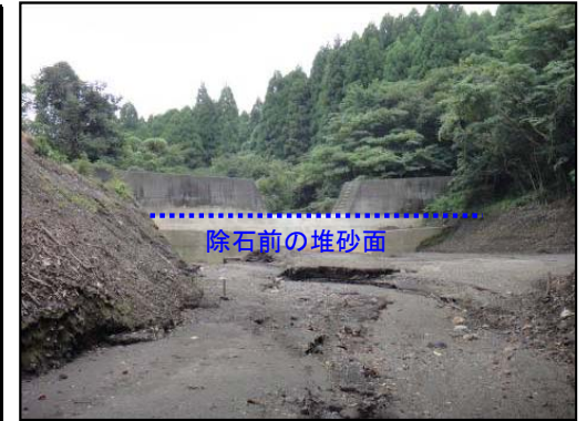
【除石後の堰堤堆砂地(新燃岳噴火時の緊急対策)】
