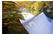
(竹田市) 「白水ダム」 国の重要文化財。水の流れが美しい白水ダム。
