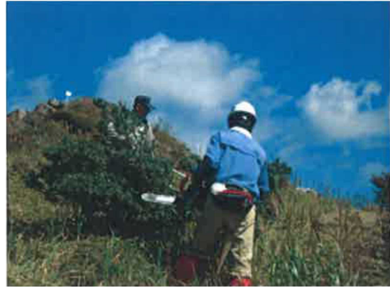
チェーンソーによる支障木（アセビ）伐採作業
