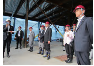
【大分県立美術館建設現場】
