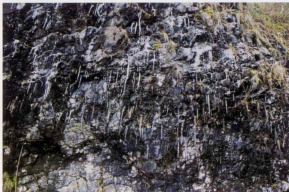
写真2. 岩壁からしみ出した地下水が凍結(2001年2月、高度750m附近)
