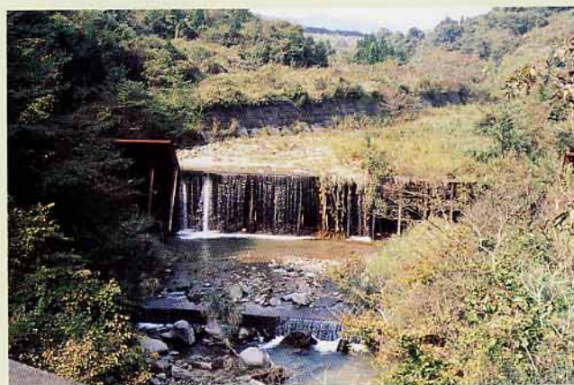
鍋谷川上重橋上流
