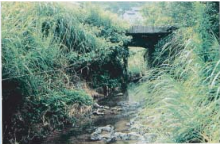
竹田川夷谷温泉下流(下の写真で奥の橋下 1995)
