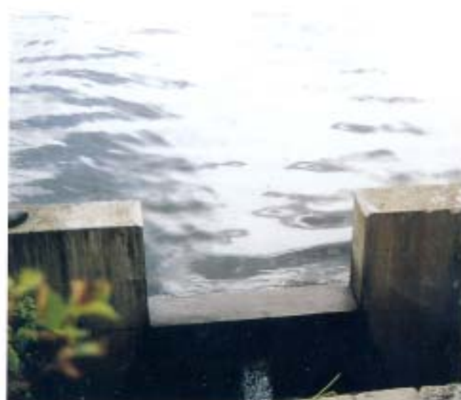
コンクリートのえん堤
