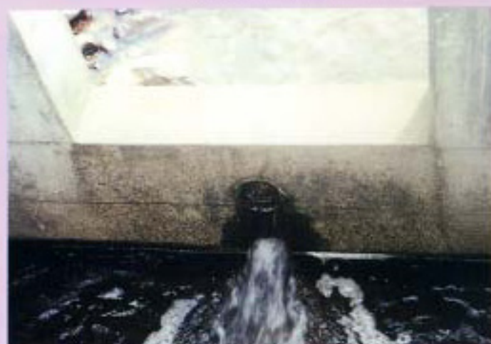
コンクリートえん堤の放水口
