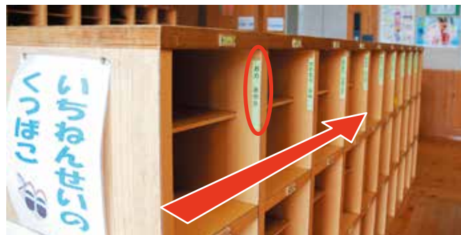
D 混雑時のトラブルを起こさないための動線に配慮した名札掲示(靴箱)
