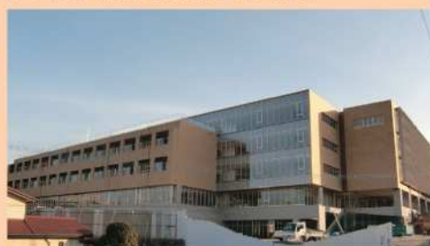
建設中の爽風館高等学校の風景
