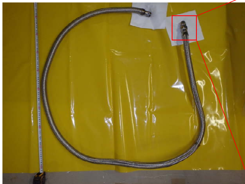
ホース全体写真
