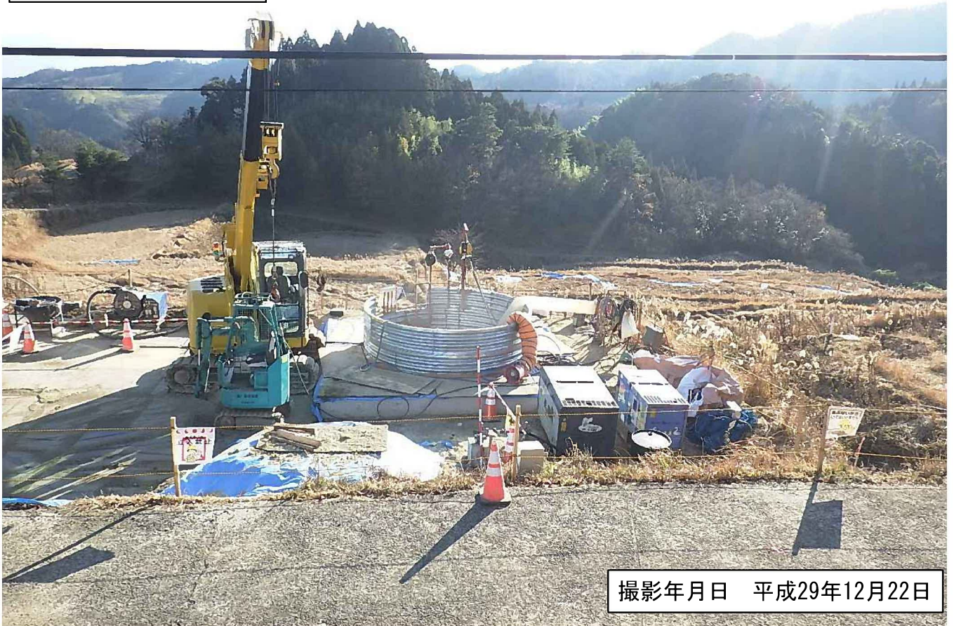
集水井 (W-1) 施工状況
