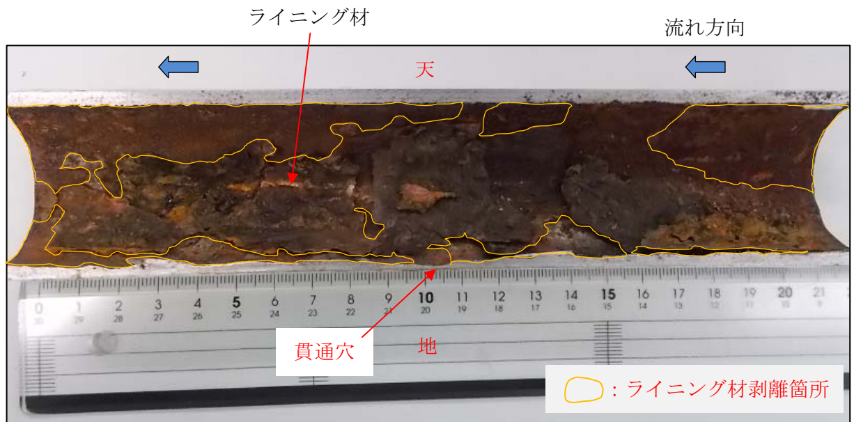
流れ方向から見て右側配管内表面
