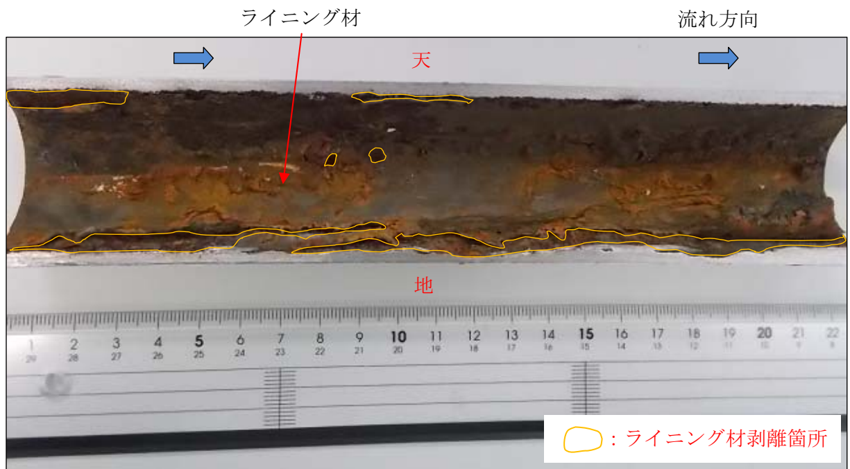
流れ方向から見て左側配管内表面
