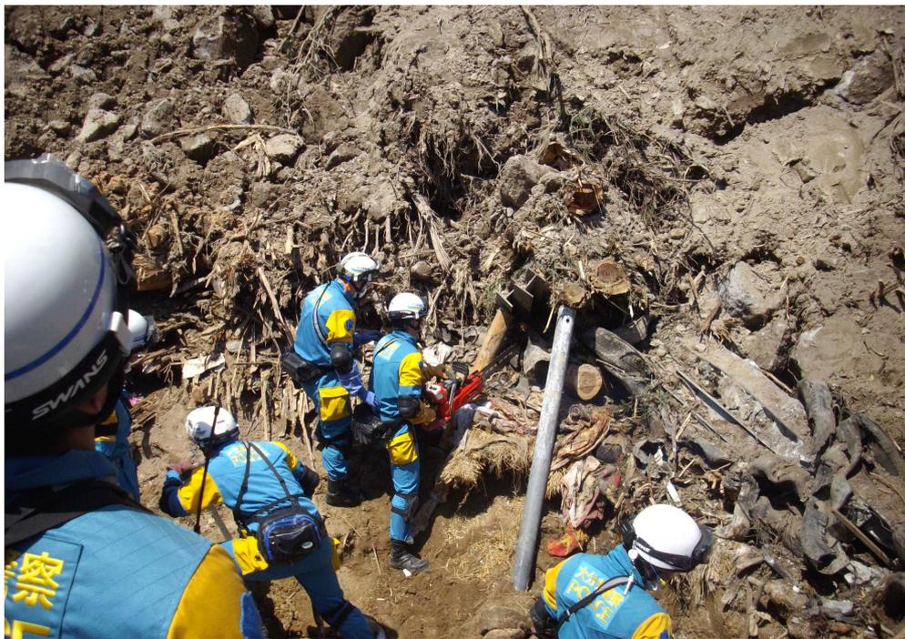
【木材や鉄柱など支柱用具を組んでの安全措置後、根切りチェーンソーを活用しての倒木切断作業】
