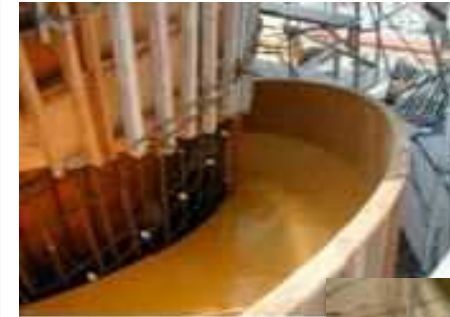
木質円形型枠 パネルを 用いた施工
