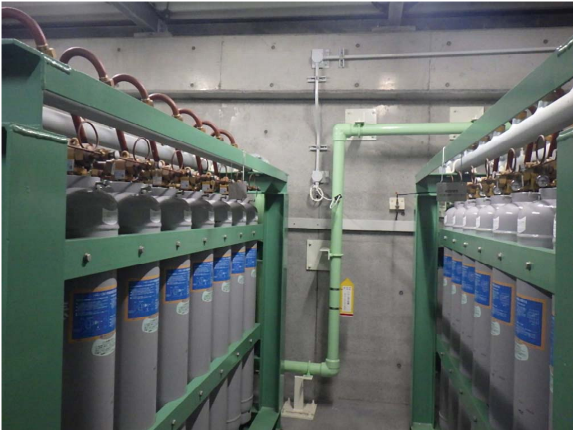
焼却炉建家ポンベ庫
