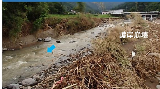
左岸崩壊による被害状況
