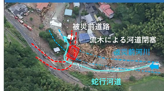
河道閉塞による被害状況
