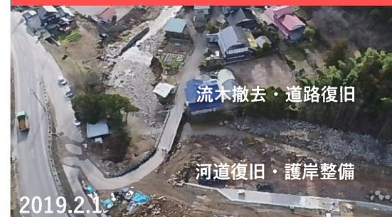
復旧状況（道路・護岸整備）
