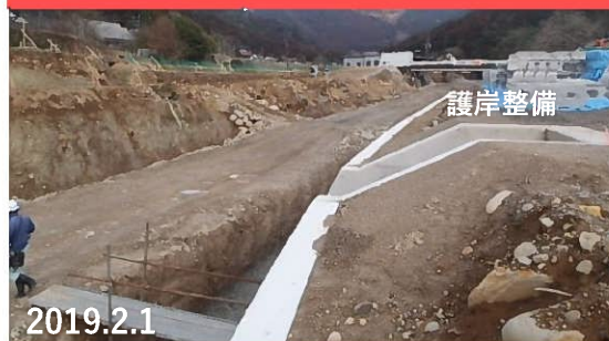
復旧状況（護岸整備）
