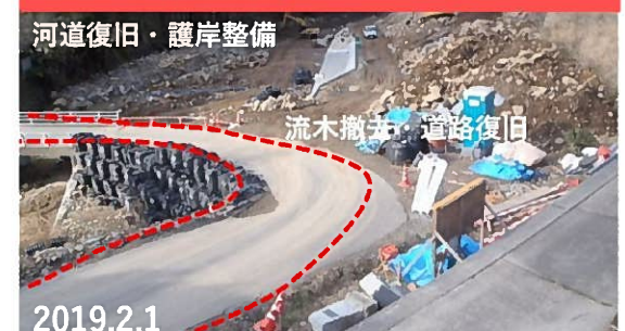
復旧状況（道路・護岸整備）
