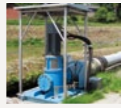
竹田市 城原井路小水力発電所
