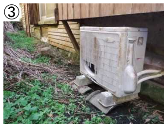
落石による破損
