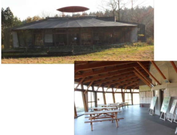
図1 県施設A 外観・内観
