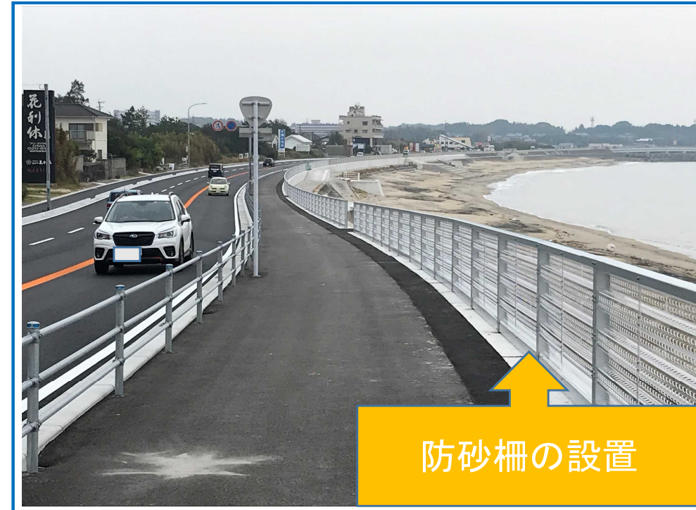
【防砂柵の設置により通行止めを軽減】
