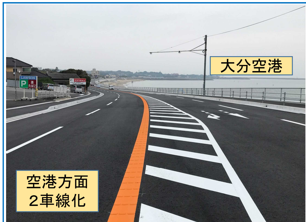
【 空港方面2車線化(完成) 】
