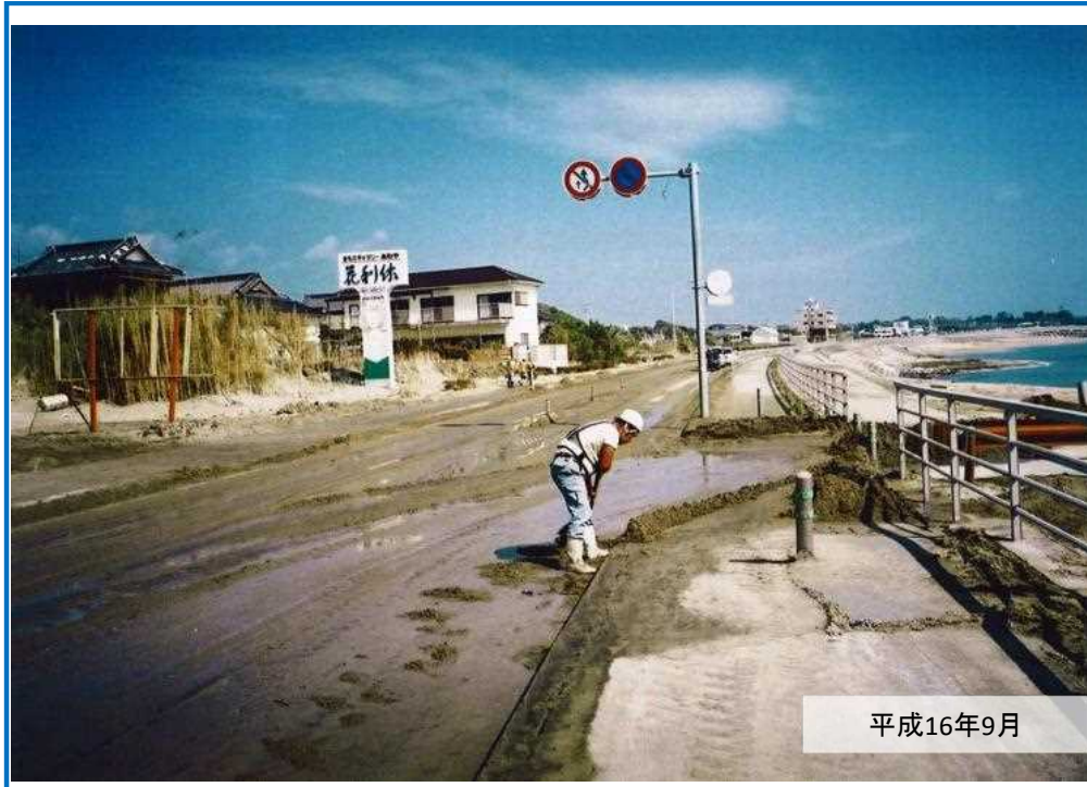
【台風による安岐海岸からの飛来砂で通行止め状況】
