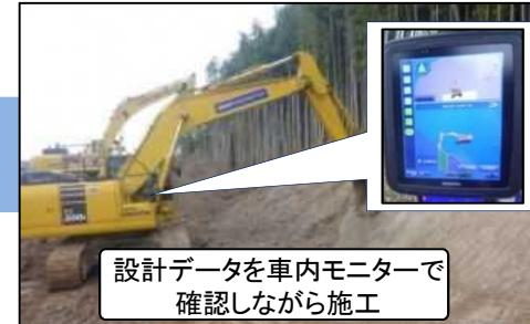
設計データを車内モニターで確認しながら施工
