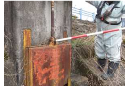
点検実施状況
