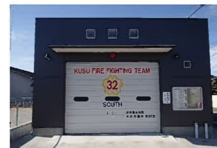
玖珠町消防団倉庫
